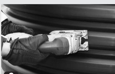
Opføringsrør afkortes i forhold til den færdige overflade og den valgte dækselløsning.
