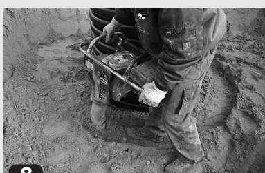
Der tilfyldes jævnt med friktionsmateriale rundt om brøden i lag (max. 30 cm), og der komprimeres løbende. Komprimering sker i henhold til de krav der stilles til konstruktionen over. I arealer med trafiklast komprimeres til min. 98% Standard Proctor. Der henvises i øvrigt til projektets beskrivelse af kote- og komprimeningsforhold mv.
