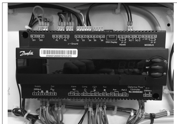
Bild 4: Normale Verdrahtung
