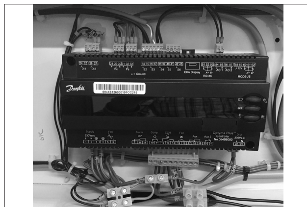
Bild 5: Tillfälliga anslutningar
