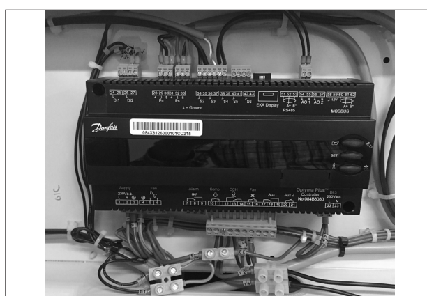
Rysunek 5: Okablowanie tymczasowe
