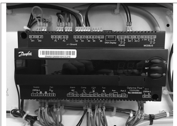
Illustration 4 : Câblage normal
