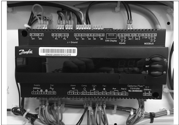
Imagem 4 : Cablagem normal
