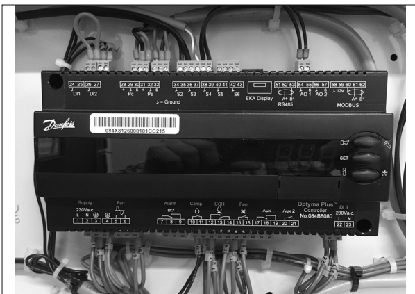
Illustration 4 : Câblage normal
