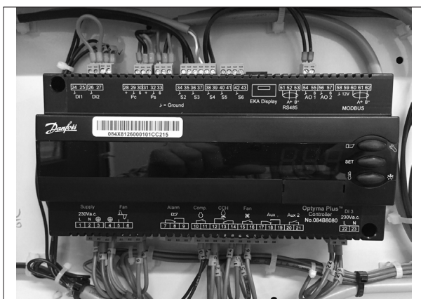
Illustration 4 : Câblage normal
