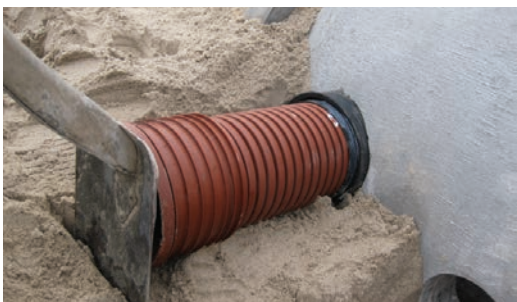
8. Skjut anslutningsröret på plats. Rekommenderas att ansluta med kort muffad rörbit, gör det lättare att kontrollera insticket.
