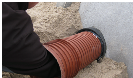
9. Kontrollera att packningen och anslutningsrör inte sticker in i huvudledning eller brunn, samt att anslutningsröret är korrekt monterat mot packningens rörstopp.
