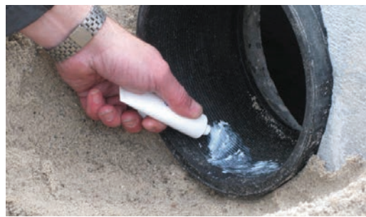
7. Påför glidmedel på såväl packning som justeringsring.
