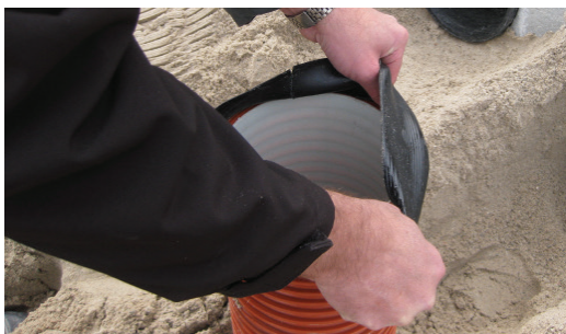
6. Montera justeringsring (JR) på anslutningsrör. Ingen justeringsring på släta rör.
