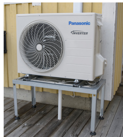
4. Montera på tvärstagen anpassat till din värmepump.
