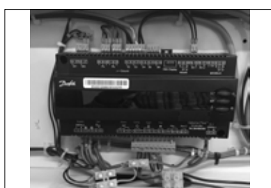
Bild 5: Vorläufige Verdrahtung für Notbetrieb
