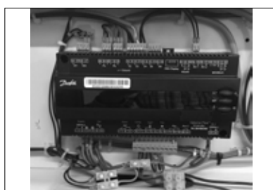
Billede 5: Midlertidig ledningsføring
